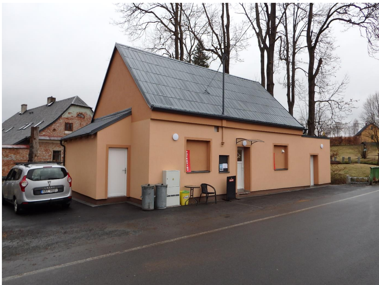
Foto kontrola Dolní Moravice – Rekonstrukce místních potravin
